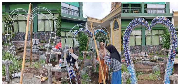
Gambar 7. Proses penyusunan ecobrick (a. kerangka spot foto, b. proses penyusunan, c. spot foto yang sudah jadi)
